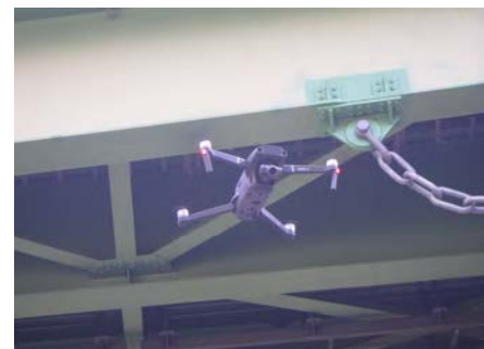
ドローンによる橋梁点検
